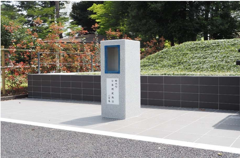
都営多磨霊園 樹林型合葬枚数施設二号基
